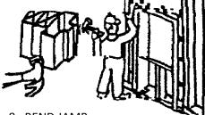
8. BEND JAMB **ANCHOR TABS** AROUND WOOD **STUDS**
